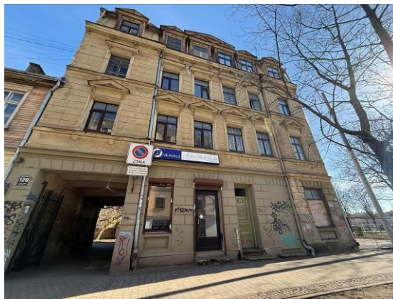
Dzīvojamā ēka no ielas puses
