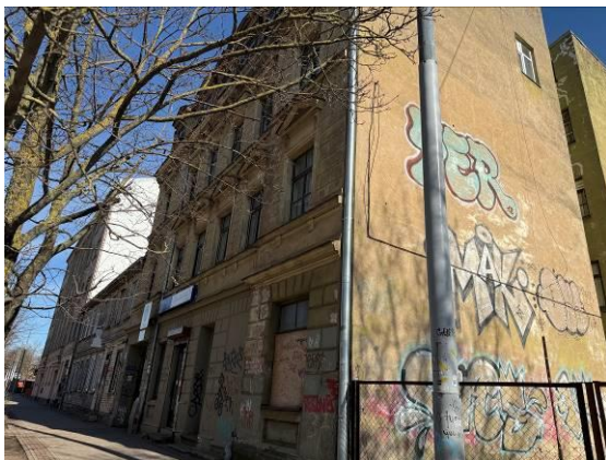
Dzīvojamā ēka no ielas puses
